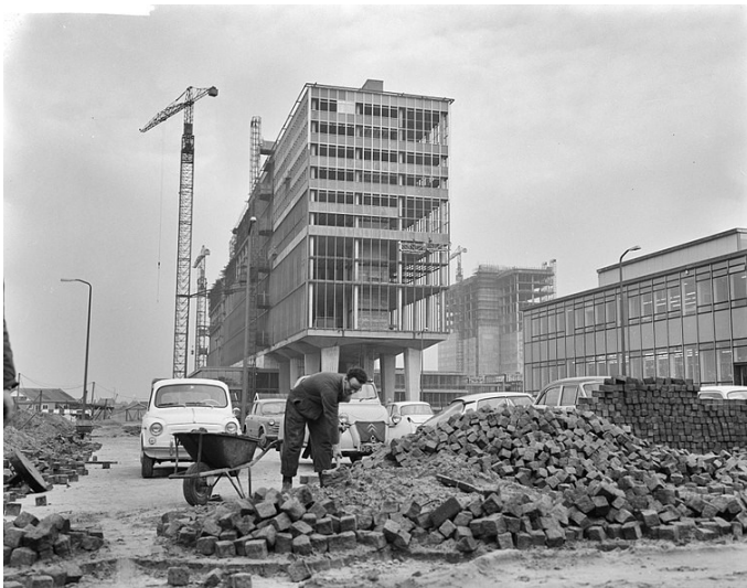
Technische Hogeschool Eindhoven in aanbouw (1962)
